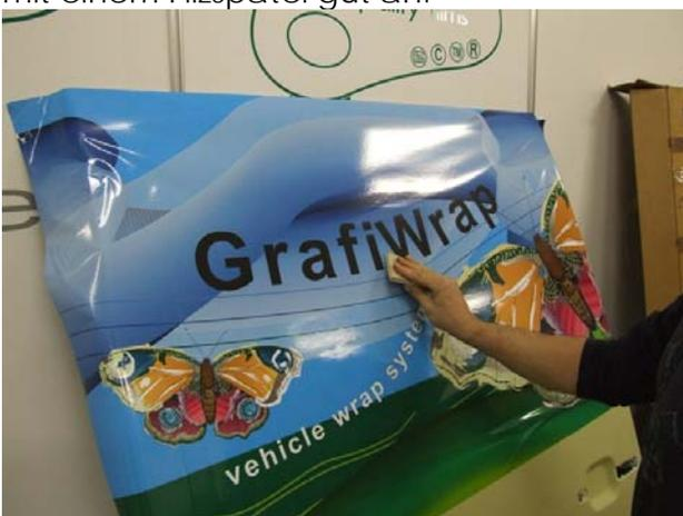
Zur Verklebung der Folie in der Vertiefung verwendet man am Besten Handschuhe – u.a. die Grafiwrap Handschuhe (GLOVE1). Dies hat den Vorteil, dass man die Folie beim Verkleben nicht beschädigt.
